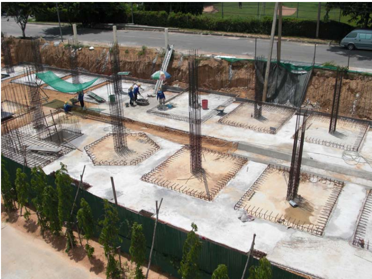
Fundamenteringen er ferdig på VN Residence 2.
